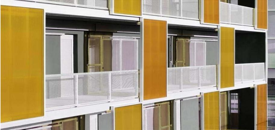
Strutture verticali a delimitazione del perimetro di un balcone, per una lunghezza non superiore ad  $1/3$  dello stesso, costituiti da elementi orizzontali o verticali orientabili, onde consentire un riparo dal vento e dalla pioggia.
